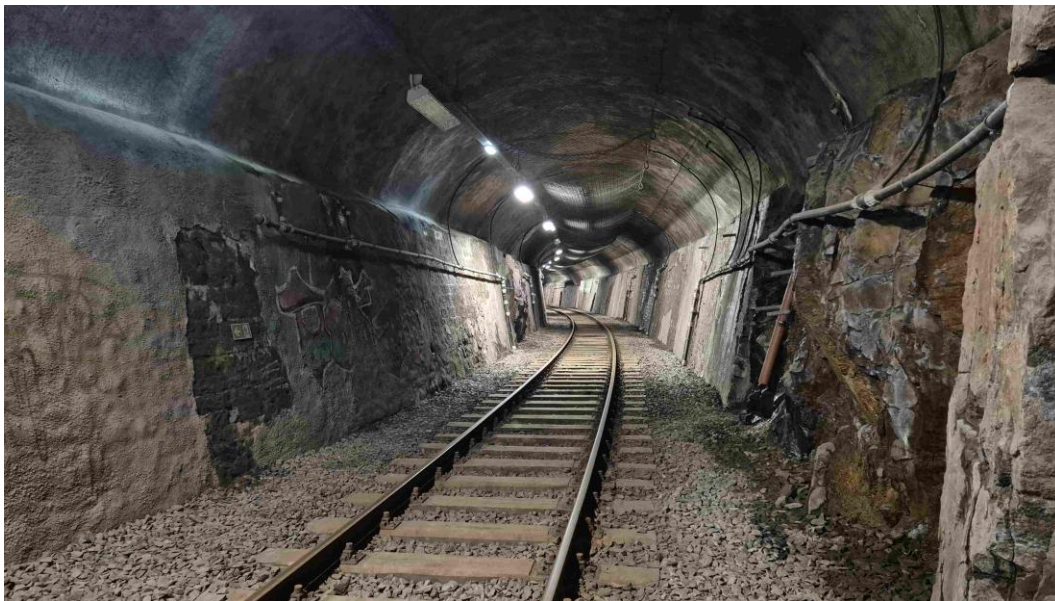
Abbildung 36: Waldmichelbacher Tunnel (Innenansicht)
