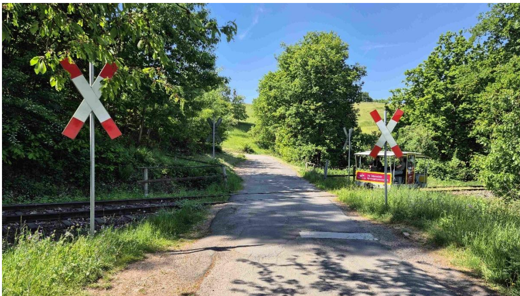
Abbildung 14: Bahnübergang Wirtschaftsweg bei km 2,45
