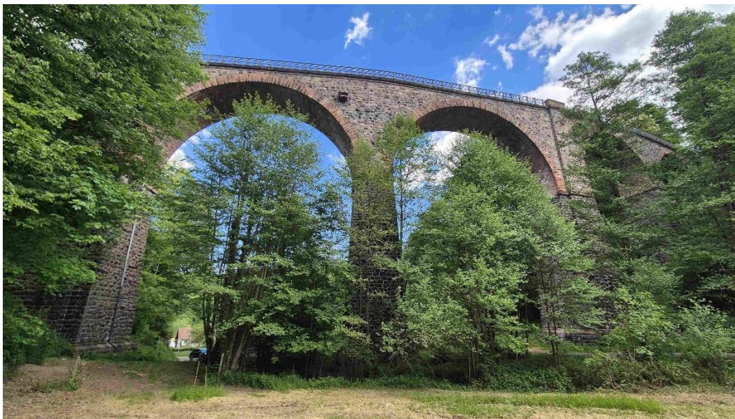
Abbildung 18: Viadukt Vöckelsbach bei km 3,695 (135m)
