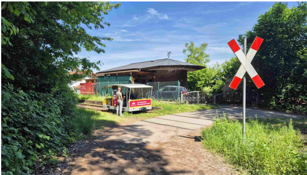
Abbildung 16: Bahnübergang am Haltepunkt Weiher bei km 2,65
