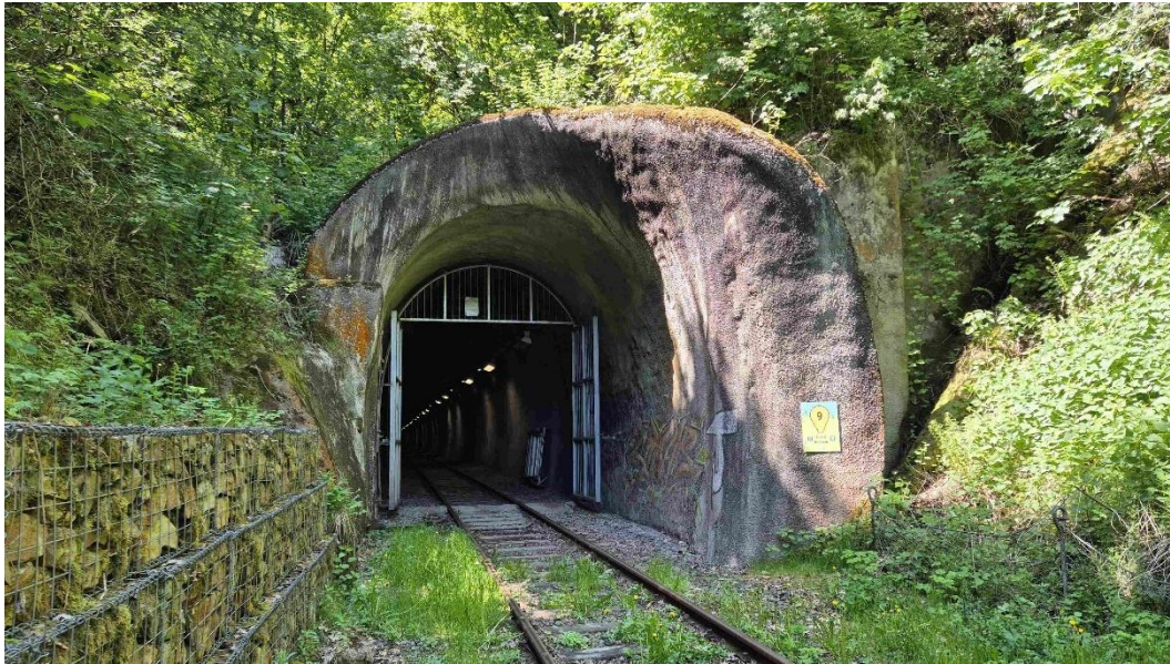
Abbildung 37: Waldmichelbacher Tunnel (Ostportal)
