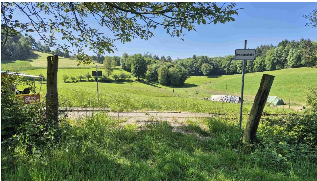
Abbildung 12: Bahnübergang Feldweg Langklingerhof bei km 1,5
