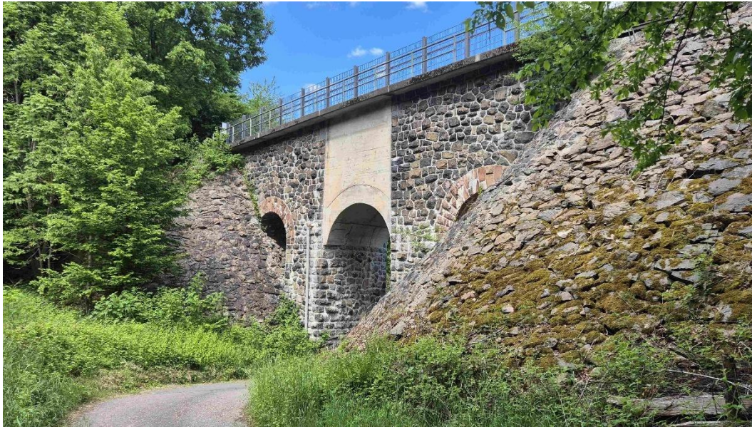
Abbildung 17: Viadukt Weiher bei km 3,255 (26m)
