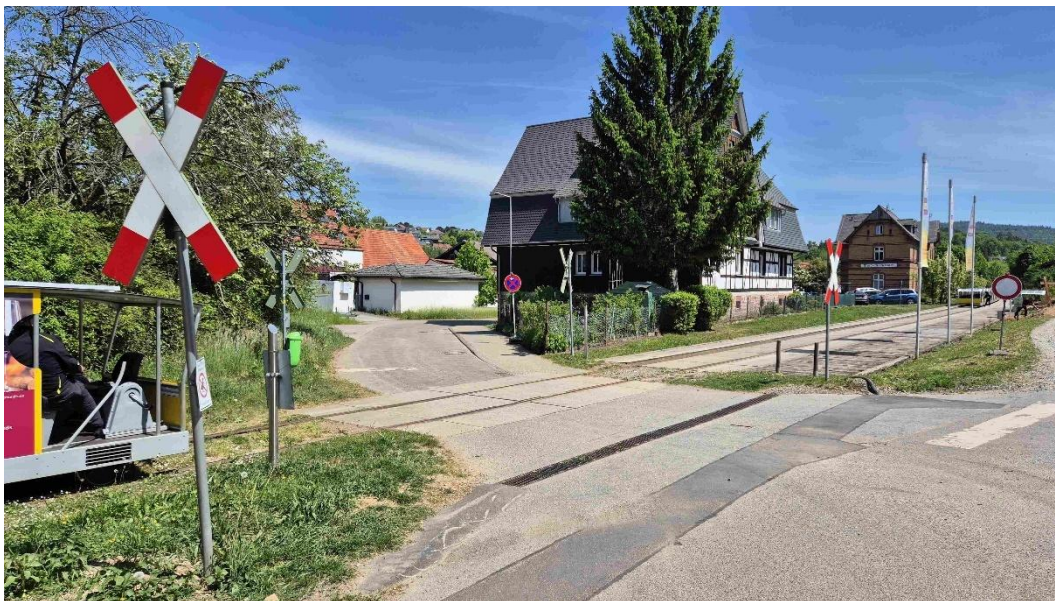
Abbildung 38: Bahnübergang der Straße „Am Bahnhof“ bei km 9,5
