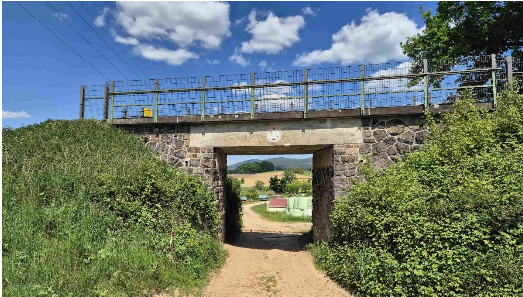
Abbildung 11: Eisenbahnüberführung Langklinger Hof bei km 1,255
