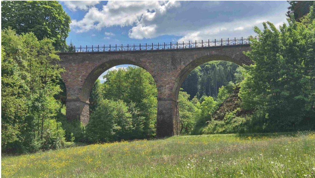
Abbildung 31: Viadukt Kreidach bei km 7,262 (80 m)
