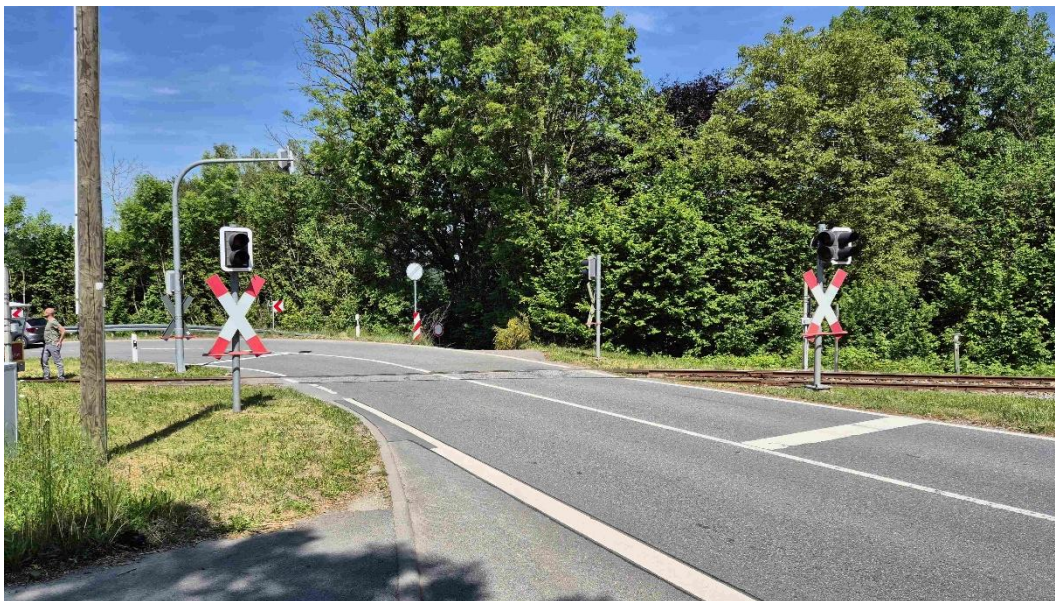
Abbildung 34: Bahnübergang L 3120 am Haltepunkt Kreidach bei km 7,9
