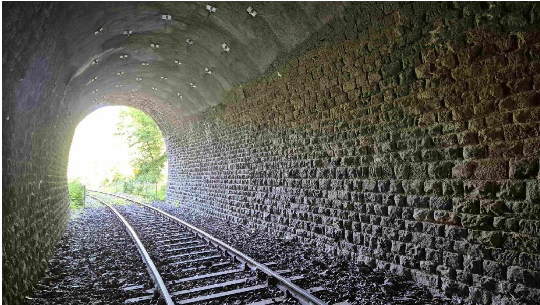
Abbildung 25: Mackenheimer Tunnel (Innenansicht)
