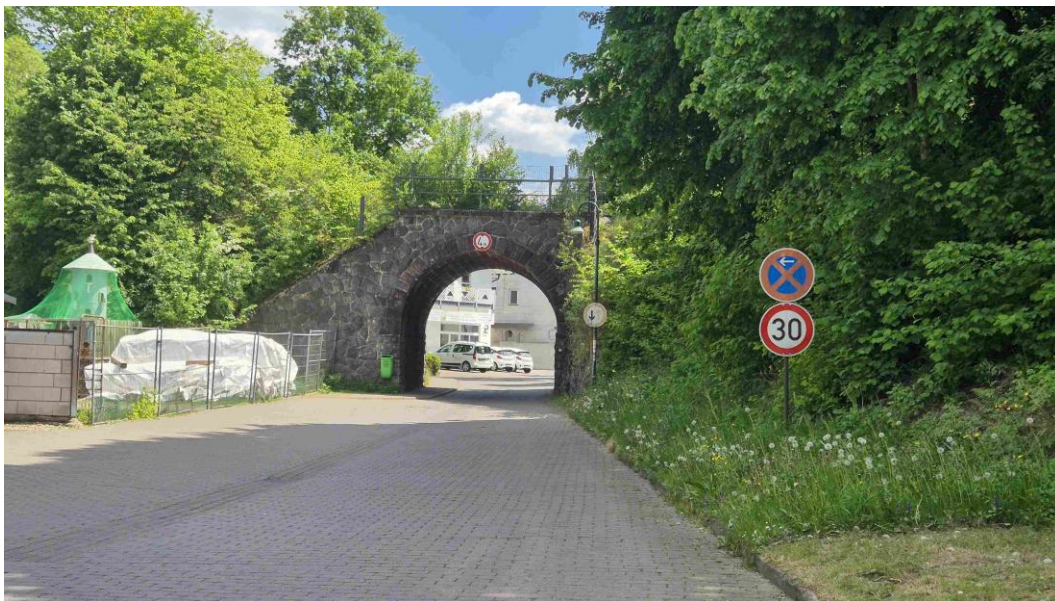
Abbildung 40: Eisenbahnüberführung Wetzkeil (km 9,820)
