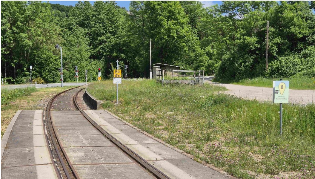
Abbildung 33: Haltepunkt Kreidach (km 7,87)
