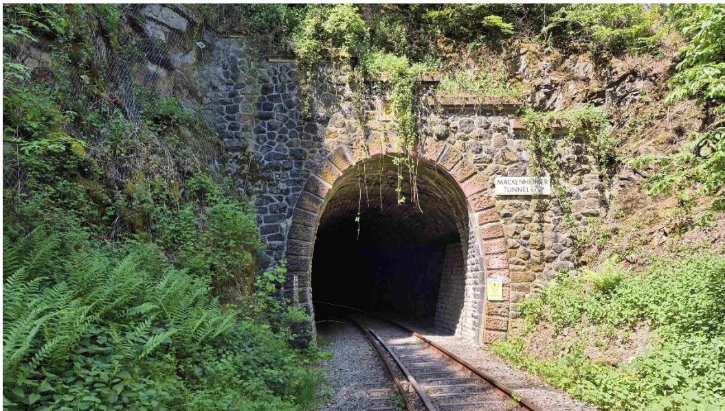
Abbildung 26: Mackenheimer Tunnel (Ostportal)
