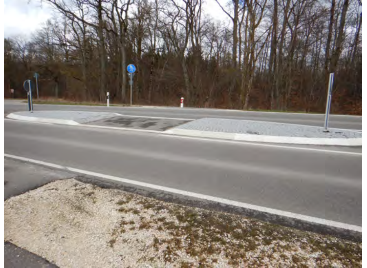
Abbildung: Beispielhafter Überführung Radweg - Fahrbahn im Alb-Donau-Kreis
