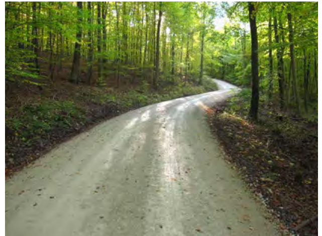
Abbildung: Beispiel gut befahrbare wassergebundene Decke
