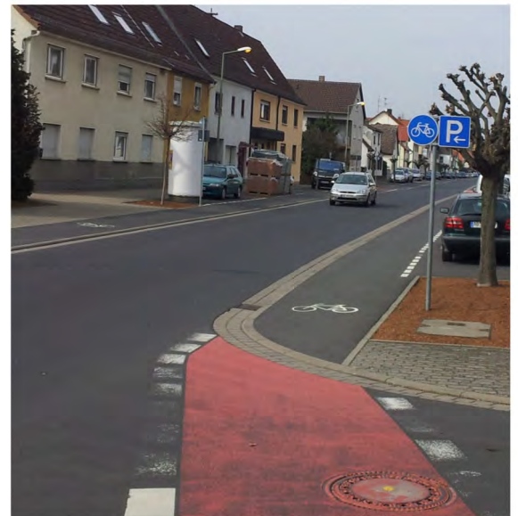
Abbildung 1: Bordsteinabsenkung Fahrbahn - Radweg, Frankfurt am Main
