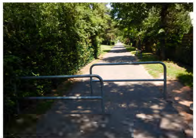
Abbildung 1: Umlaufsperrn mit zu geringer Durchgangsbreite, Überlappung der Gitter und ohne (reflektierende) Markierung
