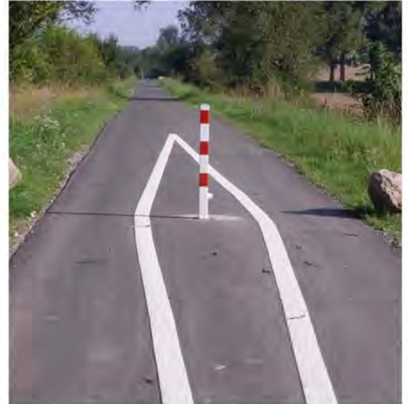
Abbildung 1: Warnmarkierung eines Sperrpfostens
